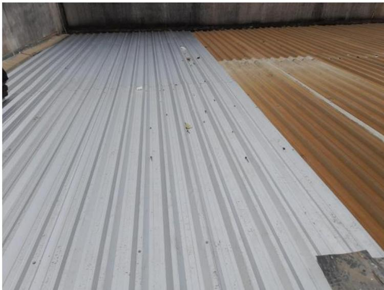
**Imagem 03** – Substituição de telhas metálicas termoacústicas
